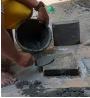
Gambar 3. Proses pencetakan beton.
